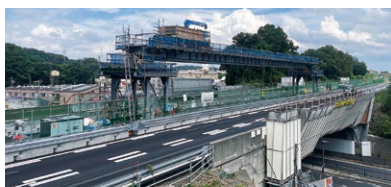
床版撤去・架設イメージ(架設桁工法)
