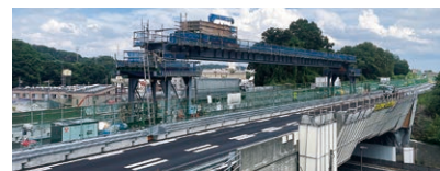
床版撤去・架設イメージ(架設桁工法)
