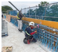
現場打ち壁高欄の施工
