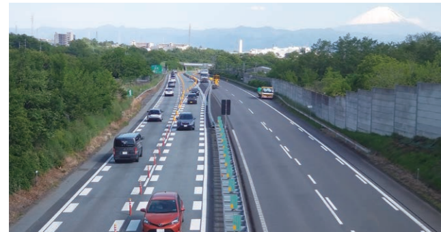
2023年に実施した対面通行規制の様子
