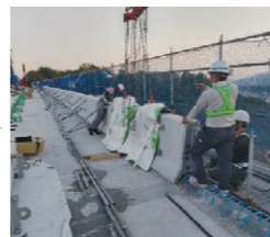
プレキャスト壁高欄の施工
